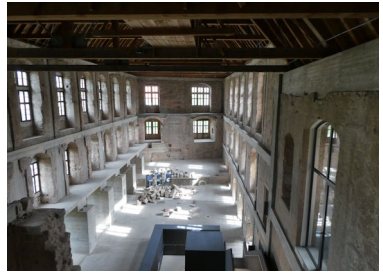
Neues Schloss, Innenraum; muss noch ausgebaut werden
